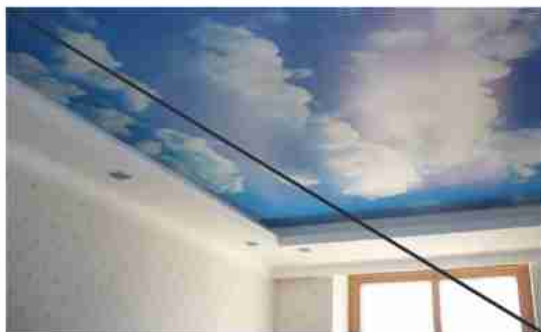
Плохо Натяжные потолки. Потолки с рисунками
