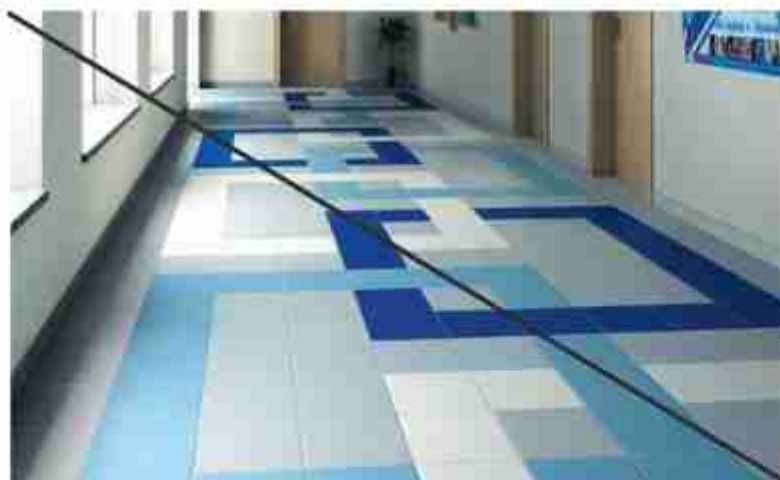
Плохо Цветные вставки из плитки
